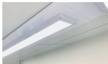
3. 照明器を設置します
