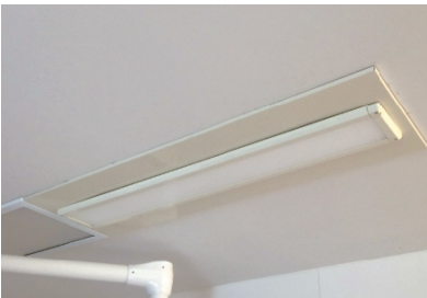
3. 照明器具を設置
