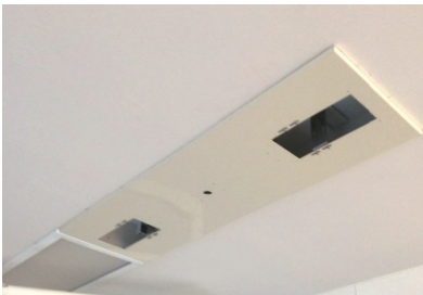
2. 既存電源から配線後、カバープレートを設置
