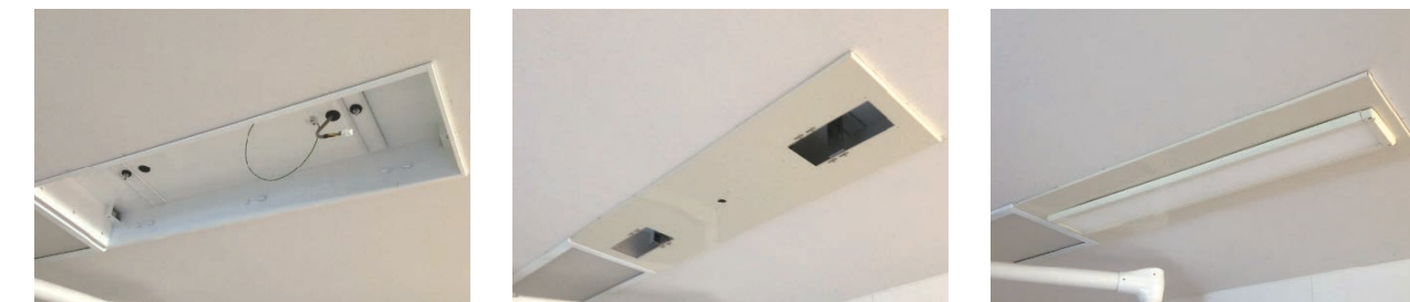
1. 蛍光灯、ソケット、安定器等既存器具を取り外す
